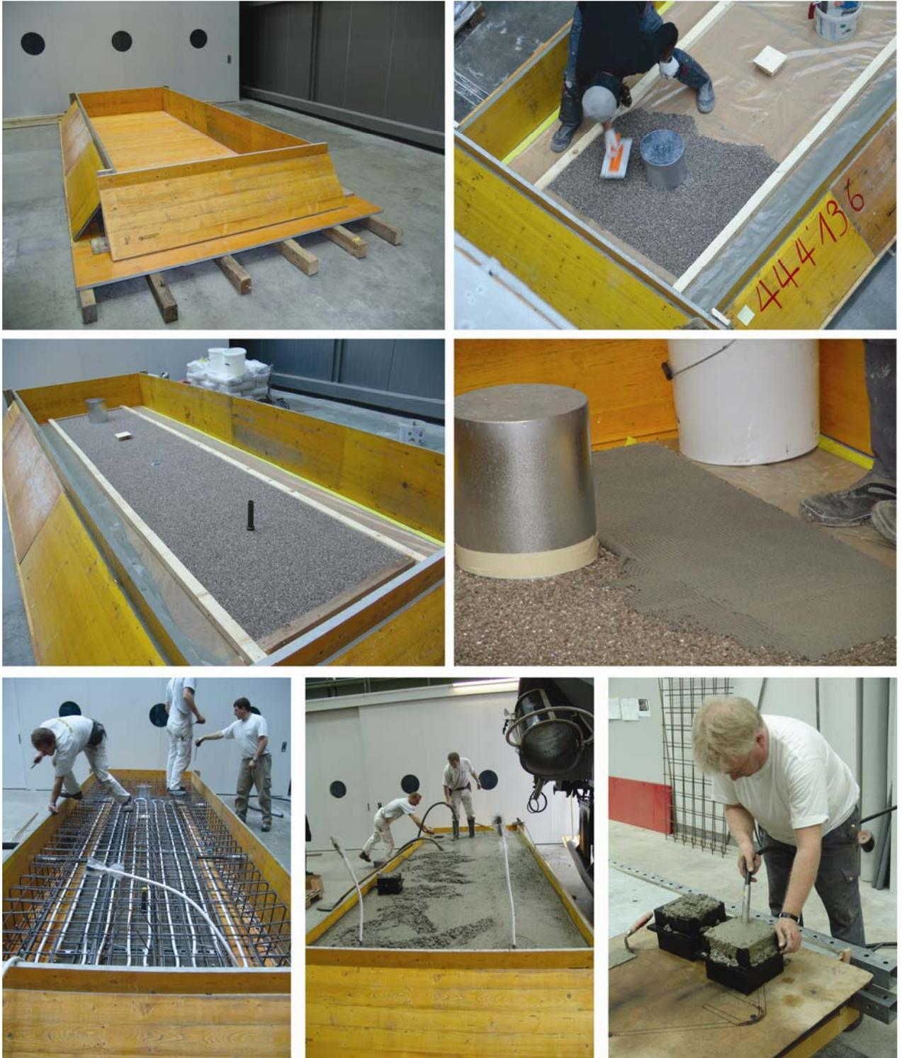
Bild 2: Herstellung der Betondecke mit der Akustikeinlage. Von oben links: Schalung – einbringen der Akustikeinlage – Akustikeinlage mit Haustechnikattrappen – Zwischenschicht – Armierung der Decke – Betonieren und vibrieren der Decke – Herstellen der Prüfwüfel.
